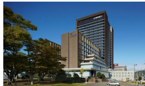
【SHIZUGIN Headquarter Tower】
