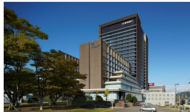
【SHIZUGIN Headquarters Tower】
