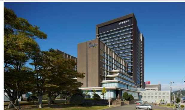
【SHIZUGIN Headquarters Tower】
