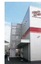
【屋上につながる外階段】
