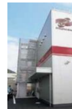
【屋上につながる外階段】
