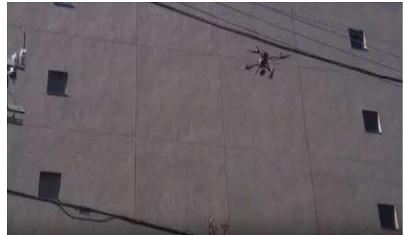
ドローンによる空撮診断
