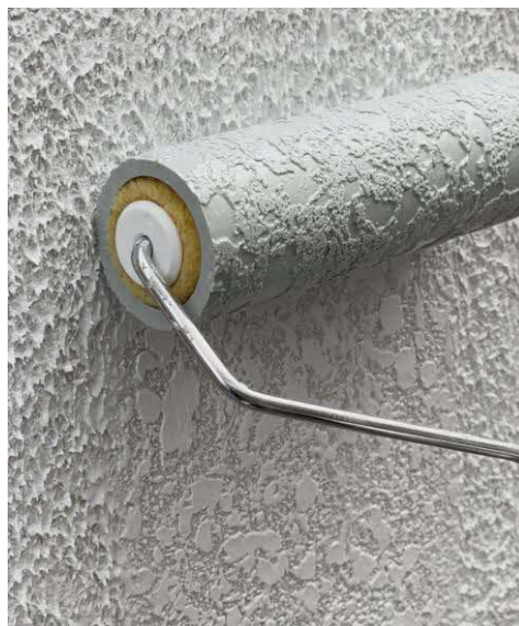
魔法ローラーによる塗装作業
