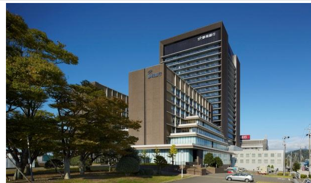
【しずぎん本部タワーの外観】
