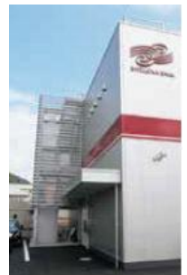
【屋上につながる外階段】
