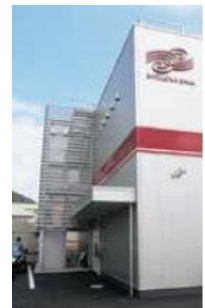
【屋上につながる外階段】
