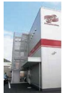
【屋上につながる外階段】
