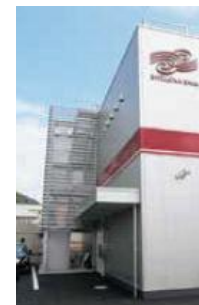
【屋上につながる外階段】
