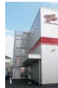
【屋上につながる外階段】
