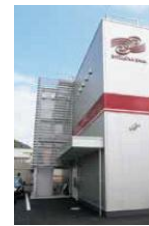
【屋上につながる外階段】
