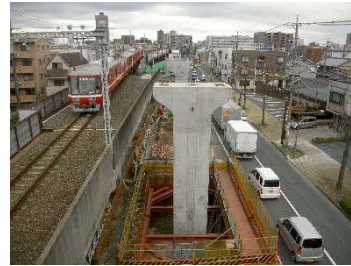
遠州鉄道鉄道線鉄道高架工事 連続立体交差事業
