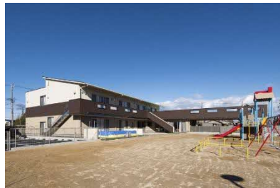
建築事業浜名愛ノ宮保育園 新築工事
