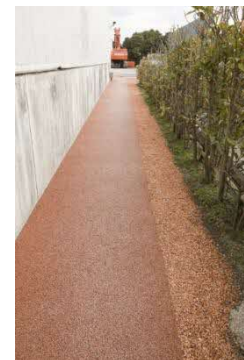
▲ 施工された K-グラウンド
