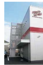
【屋上につながる外階段】
