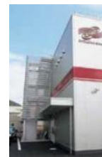
【屋上につながる外階段】
