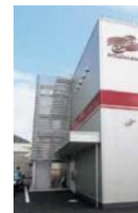
【屋上につながる外階段】
