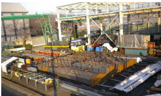
▲工場建設前の加工場の様子（2015 年時点）
