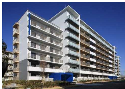
PFI 事業 (県営住宅今沢団地)
