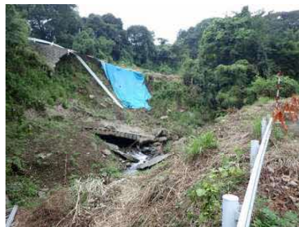
駒瀬川の雨水貯留地進入路の法面復旧工事
