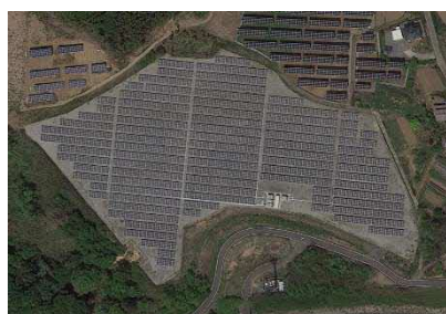
黒熊発電所（群馬県高崎市）
