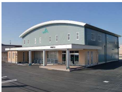
建設事業 (金融機関店舗)
